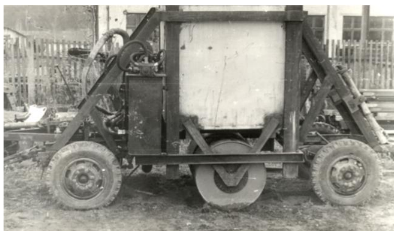
Рис. 2. Общий вид грунтоуплотняющей машины с вальцовым рабочим органом
